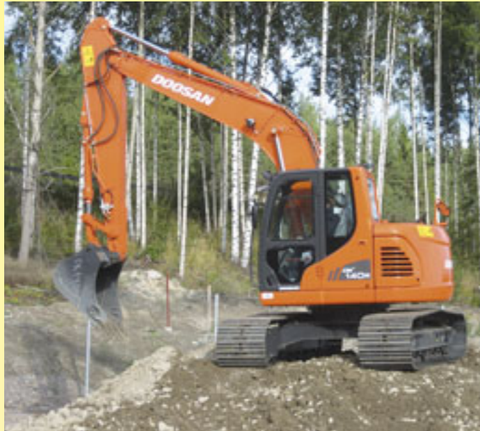
Kaivukoneita eri kokoluokissa Mörinöllä riittää. Dae-Tek Oy esittelee mm. uusimpana Doosan-mallina 14 tonnin kokoluokkaan lyhytperäisen DX140R kaivukoneen.
